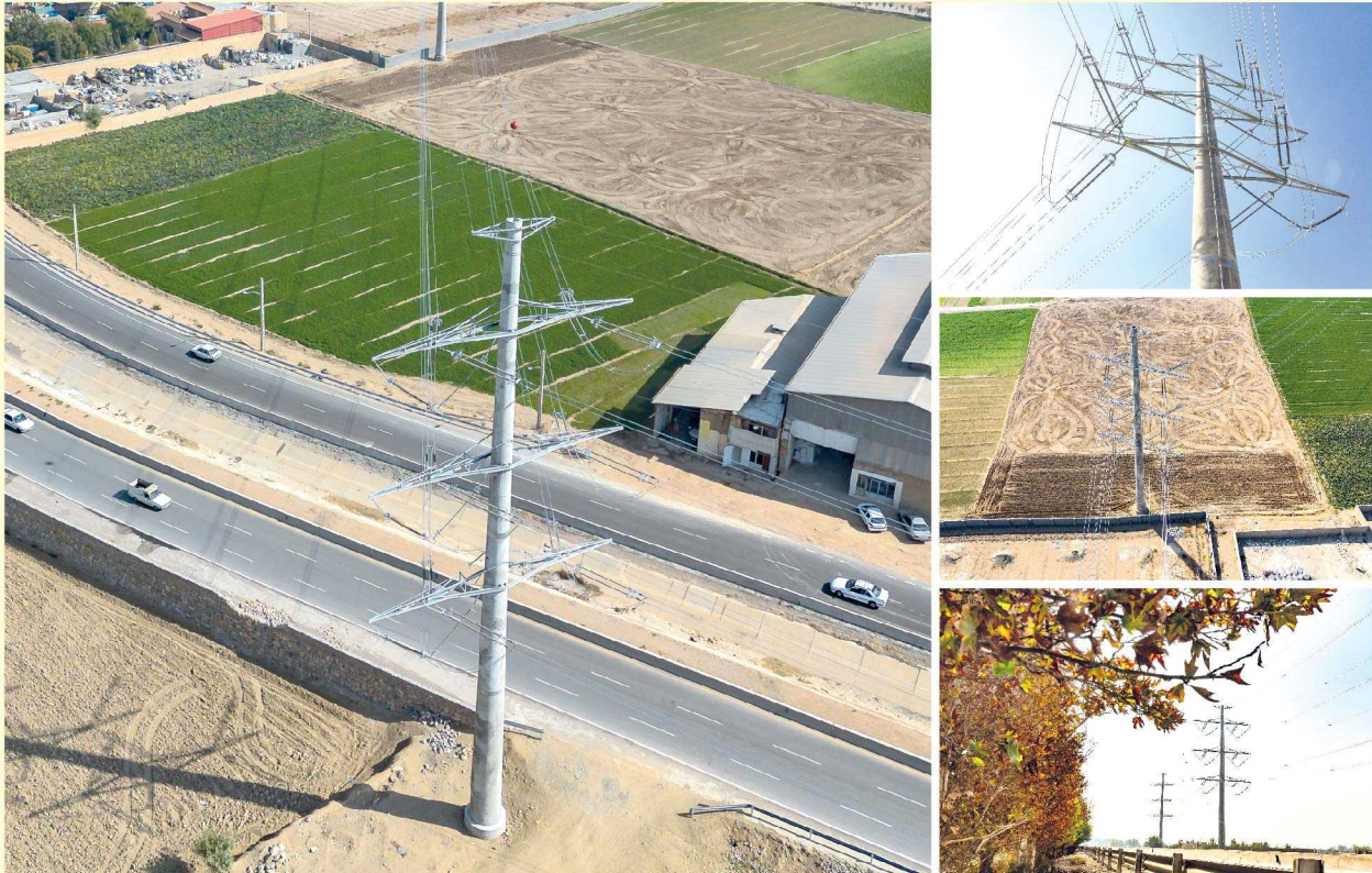
خط انتقال ۴۰۰ کیلوولت دومداره "سپاهان - جی" در شهر اصفهان با استفاده از دکل های تک پایه خودایستای بتنی
